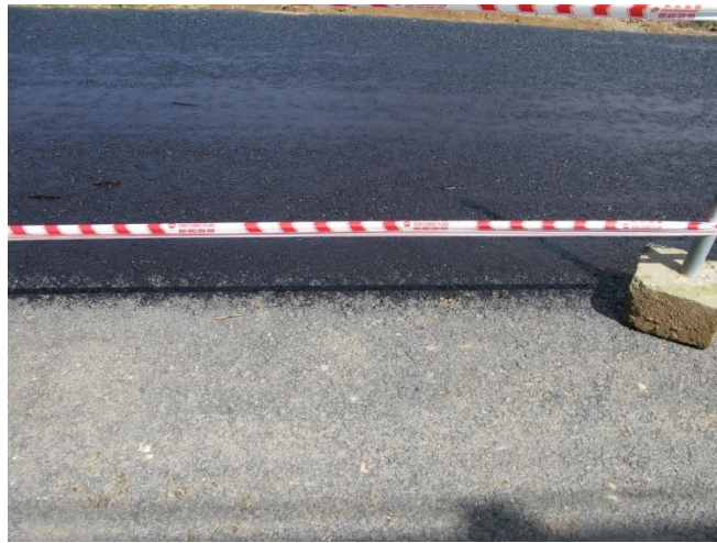
Hình 1. Tưới lớp nhựa dính bám trên bề mặt lòng đường thi công
