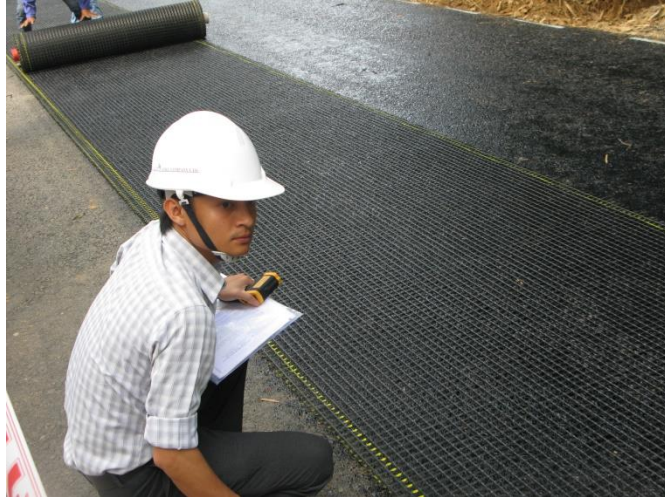
Hình 3. Trải lớp lưới địa cốt sợi thủy tinh Glasgird
