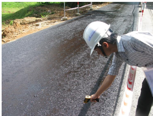
Hình 2. Kiểm tra nhiệt độ lớp nhựa tưới dính bám
