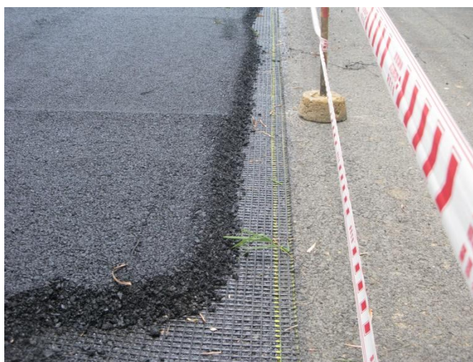
Hình 7. Rải lớp bê tông nhựa mặt trên lên lớp lưới địa cốt sợi thủy tinh Glasgird
