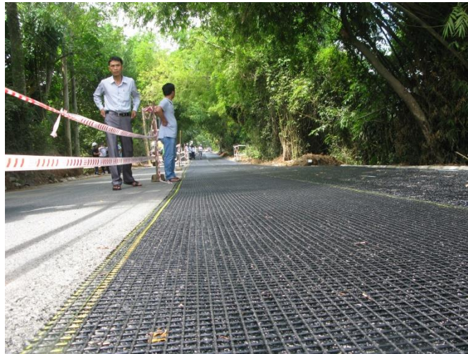
Hình 4. Bề mặt sau khi trải lớp lưới địa cốt sợi thủy tinh Glasgird
