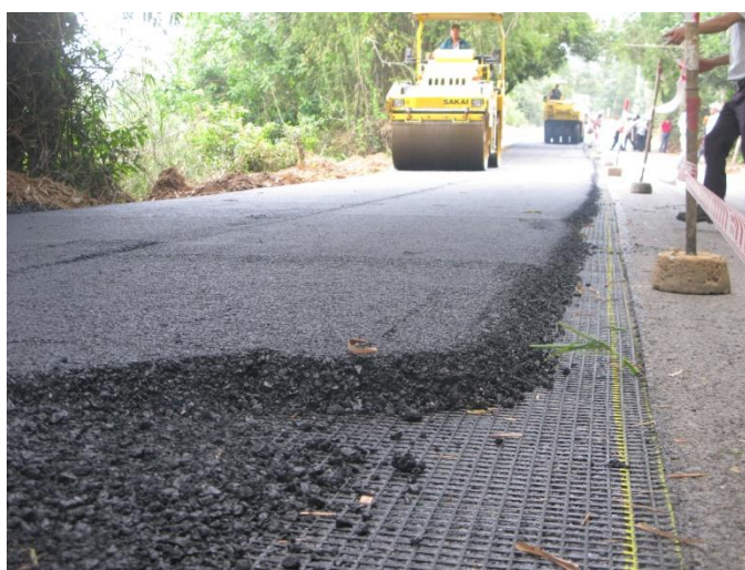
Hình 7. Lu lèn lớp mặt bê tông nhựa trên lên lớp lưới địa cốt sợi thủy tinh Glasgird
