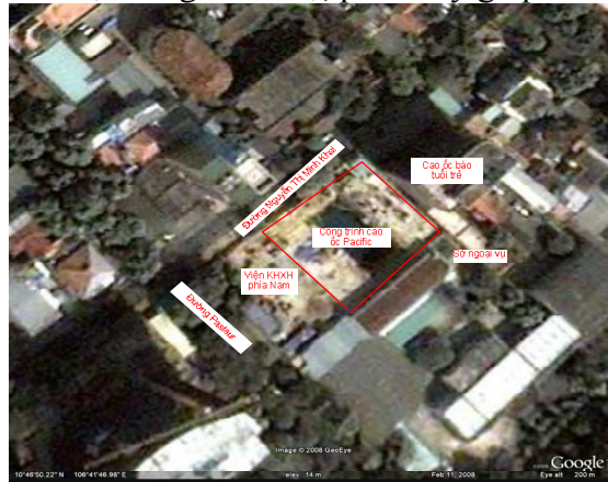
Hình 1. Vị trí công trình cao ốc PACIFIC
