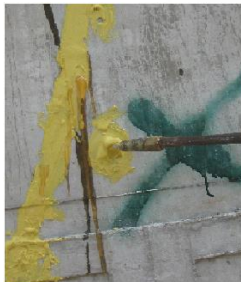
Tiến hành bơm keo vào bên trong tại các vị trí đã gắn kim bơm
