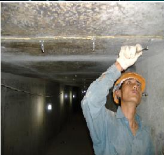
Công tác gắn kim bơm vào vị trí đã khoan
