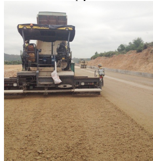
Hình 3.6. Rải cấp phối
