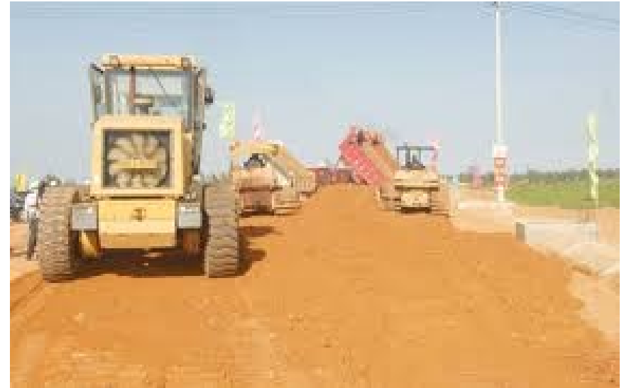
Hình 3.1. Thi công mặt đường cấp phối
