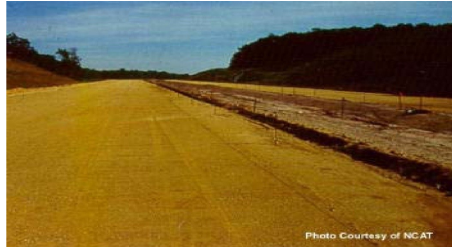
Hình 3.2. Lòng đường sau khi thi công
