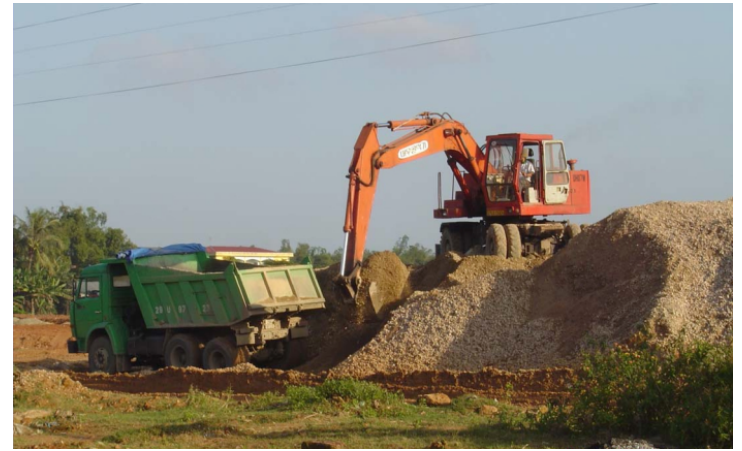
Hình 3.3. Xúc vật liệu cấp phối bằng máy đào
