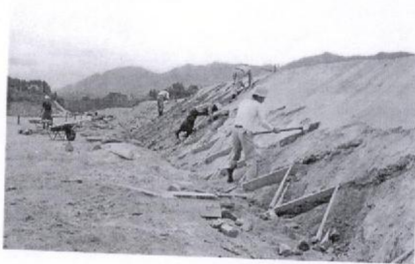
d) Đặt cốt trên mặt mái dốc
