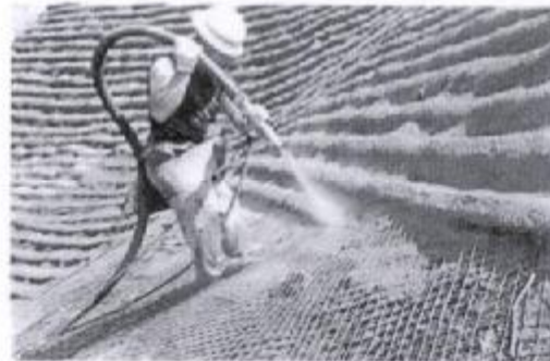
b) Bảo vệ bằng phương pháp phun bê tông có lớp lưới thép phủ mặt
